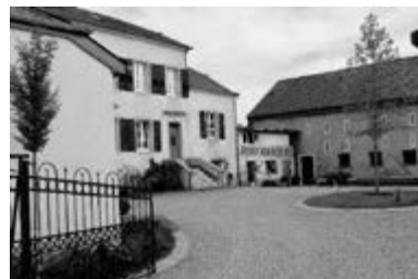
und von « heute » – vor dem aktuellem Umbau
